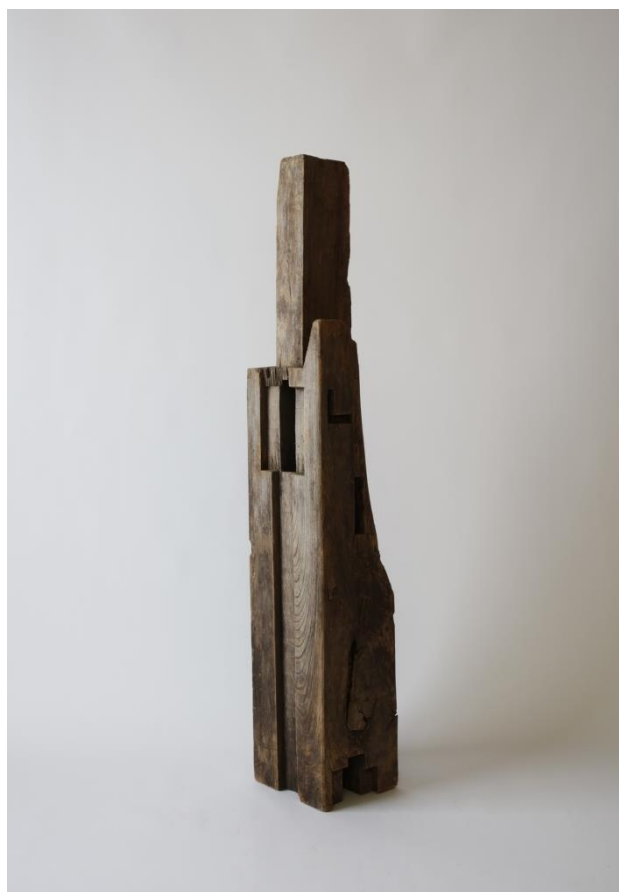
写真 1:仕口が施された柱(部分)。樺材。200年以上前の白山麓の民家の仕口。
