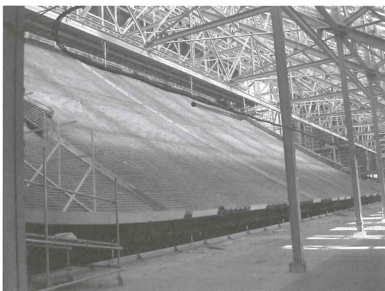
図1：東本願寺 御影堂修復工事 瓦をおろした屋根
