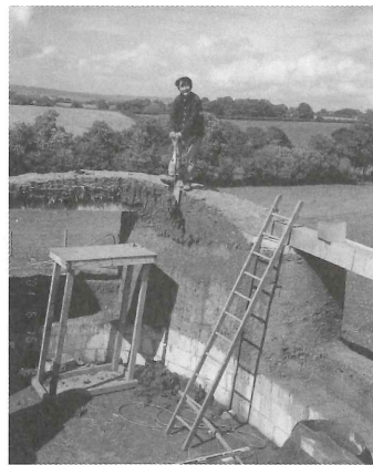
壁の上での作業(イギリス)
