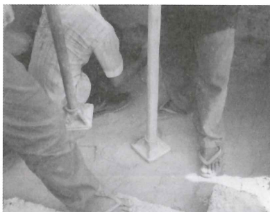
アンコール遺跡修復工事 突き固め
