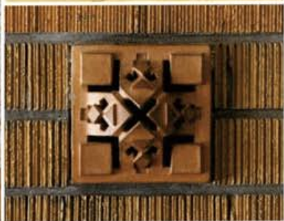
右上:ライトがデザインした照明・換気用のテラコッタの図面 Drawings of Frank Lloyd Wright are Copyright ©2007 The Frank Lloyd Wright Foundation, Taliesin West, Scottsdale, AZ 右下:照明・換気用のテラコッタ(博物館明治村) 左上・下:博物館明治村
